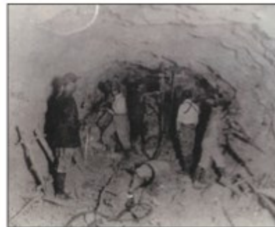
隧道掘鑿作業
