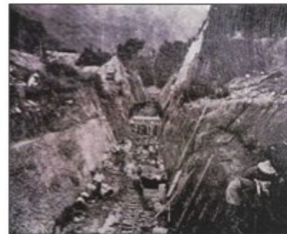
東口隧道掘鑿作業
